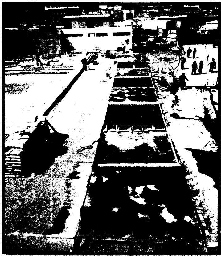
FOTOGRAFIA 01: Acero y encofrado en patio de maniobras.
